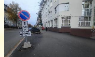
Благоустройство территории перед зданием № 73 по ул. Ленина
